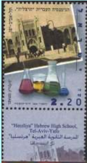
גוטמן למד בגימנסיה הרצליה.
